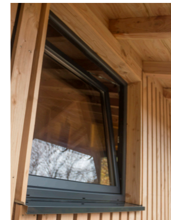
Vue extérieure - Finition bois à claire voie en Pin Douglas
